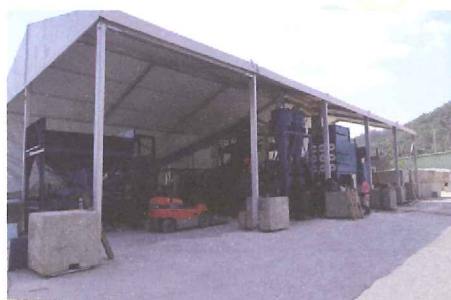
位於屯門龍鼓灘的玻璃樽回收廠內設有巨型音頻破碎系統。
